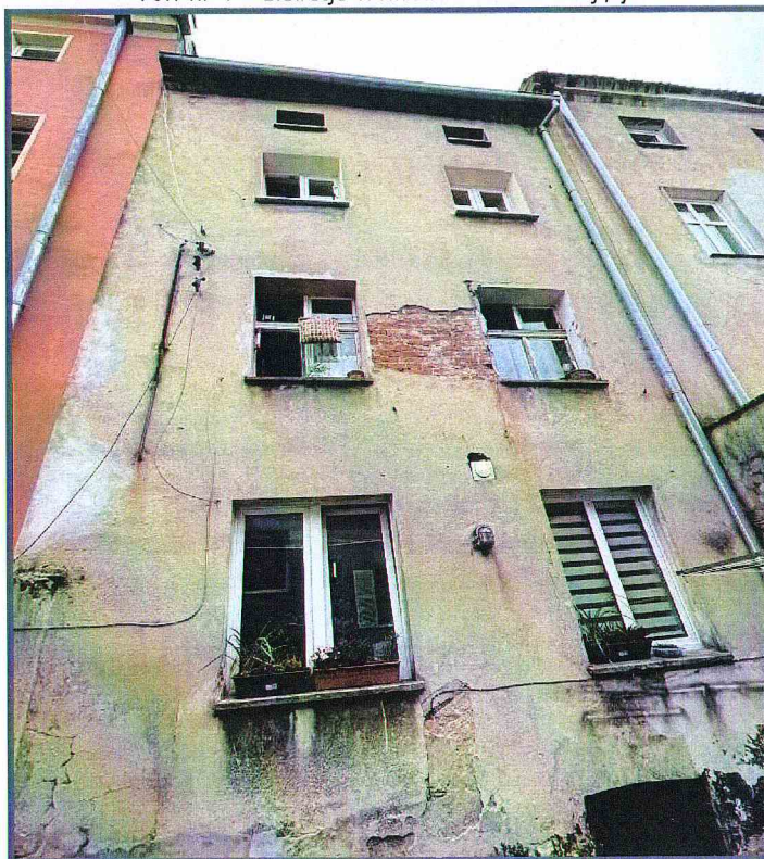
Fot. Nr 2 - Elewacja tylna - stan istniejący.
