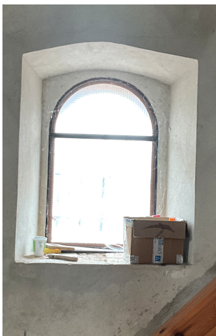
Istniejące okna w poziomie parteru przeznaczone do zamontowania parapetów kamiennych.
