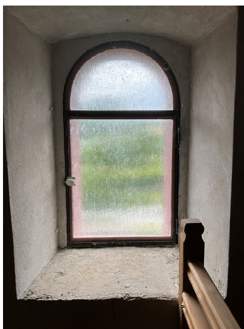
Istniejące okna w poziomie empiry muzycznej przeznaczone do zamontowania parapetów kamiennych.
