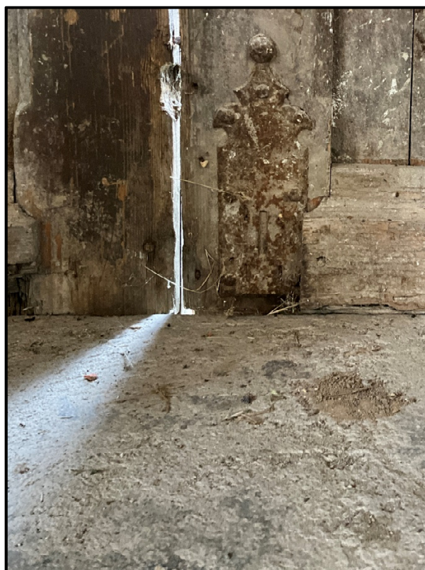
Istniejące dolne okucia drzwi – do zachowania i renowacji.
