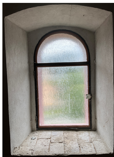
Istniejące okna w poziomie empiry muzycznej przeznaczone do zamontowania parapetów kamiennych.
