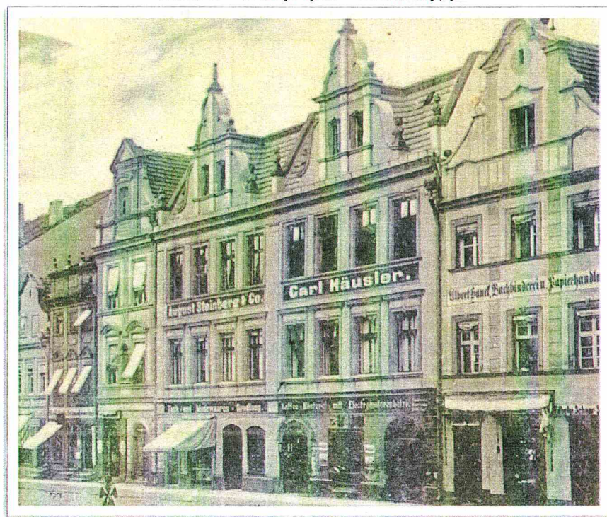
Fot. nr 4 - Elewacja frontowa - zdjęcie archiwalne.
