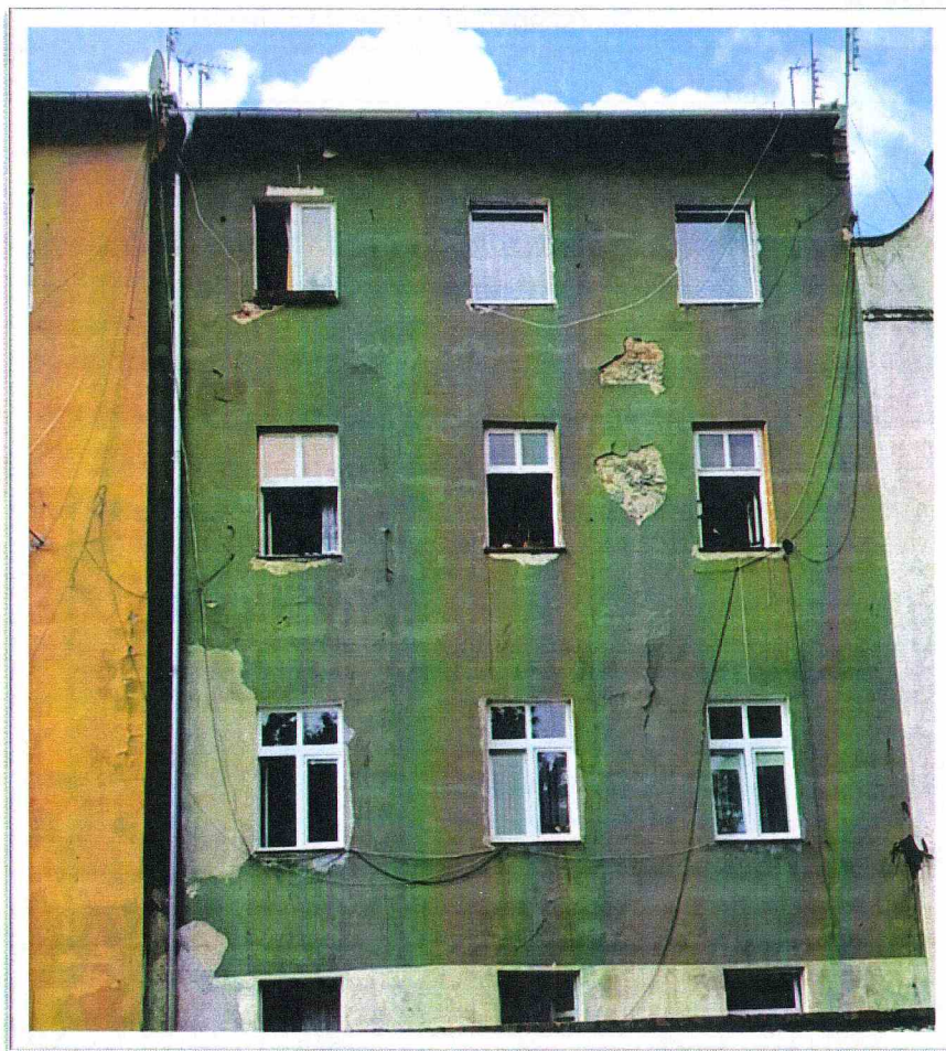
Fot. Nr 3 - Elewacja tylna - stan istniejący.
