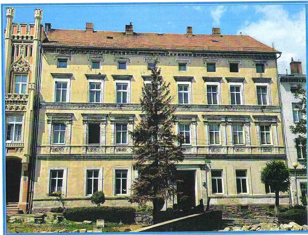
Fot. Nr 1 - Elewacja frontowa - stan istniejący.
