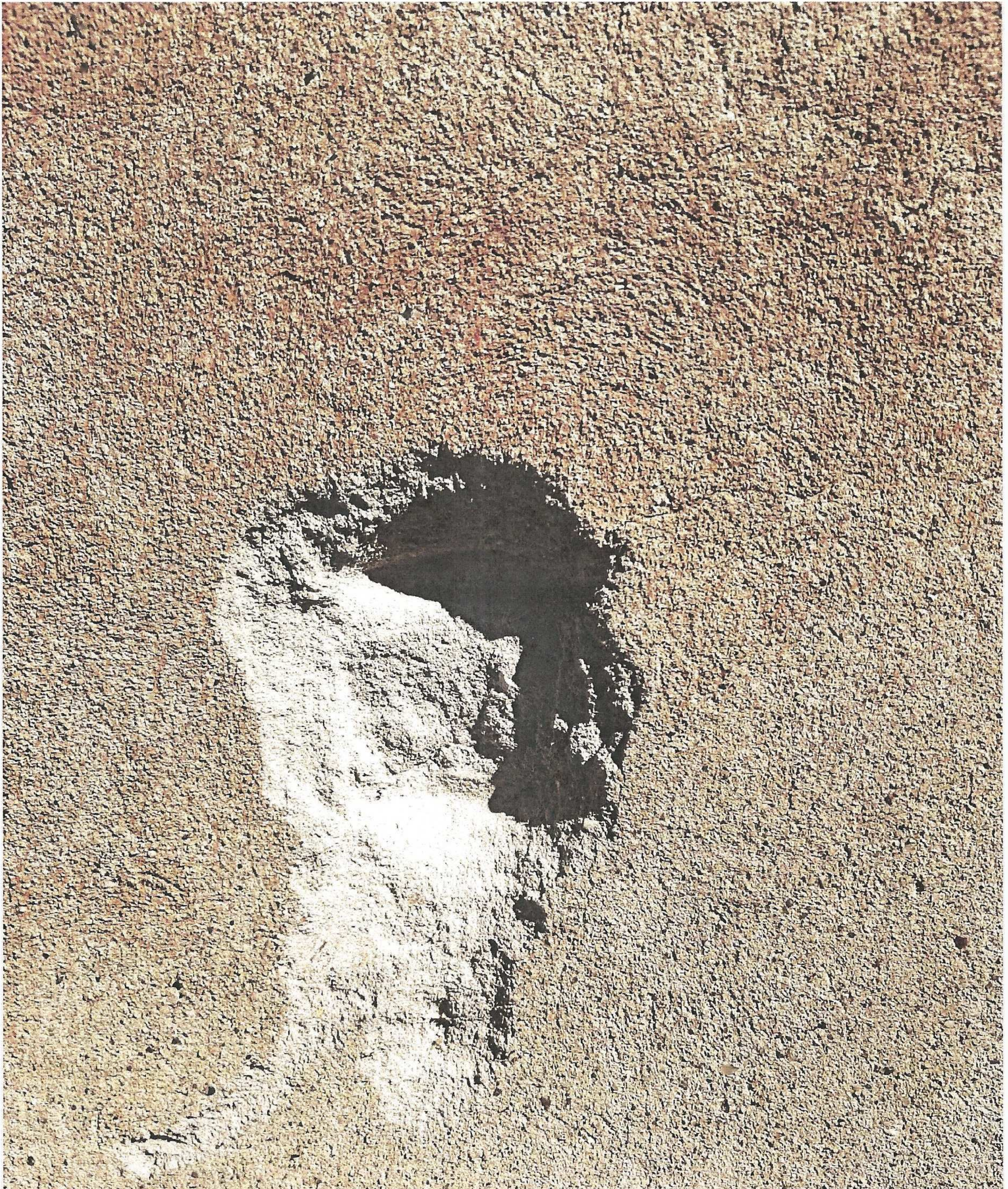
Fot. 28 . Kościół p.w. Świętej Jadwigi Śląskiej w Gilowie ; fragmenty elewacji ciągu elewacji południowej ; widoczna gładka powierzchnia tynku wapiennego ze znacznie lepiej zachowana malaturą ; struktura tynku i jego grubość tak jak na pozostałych elewacjach korpusu.
