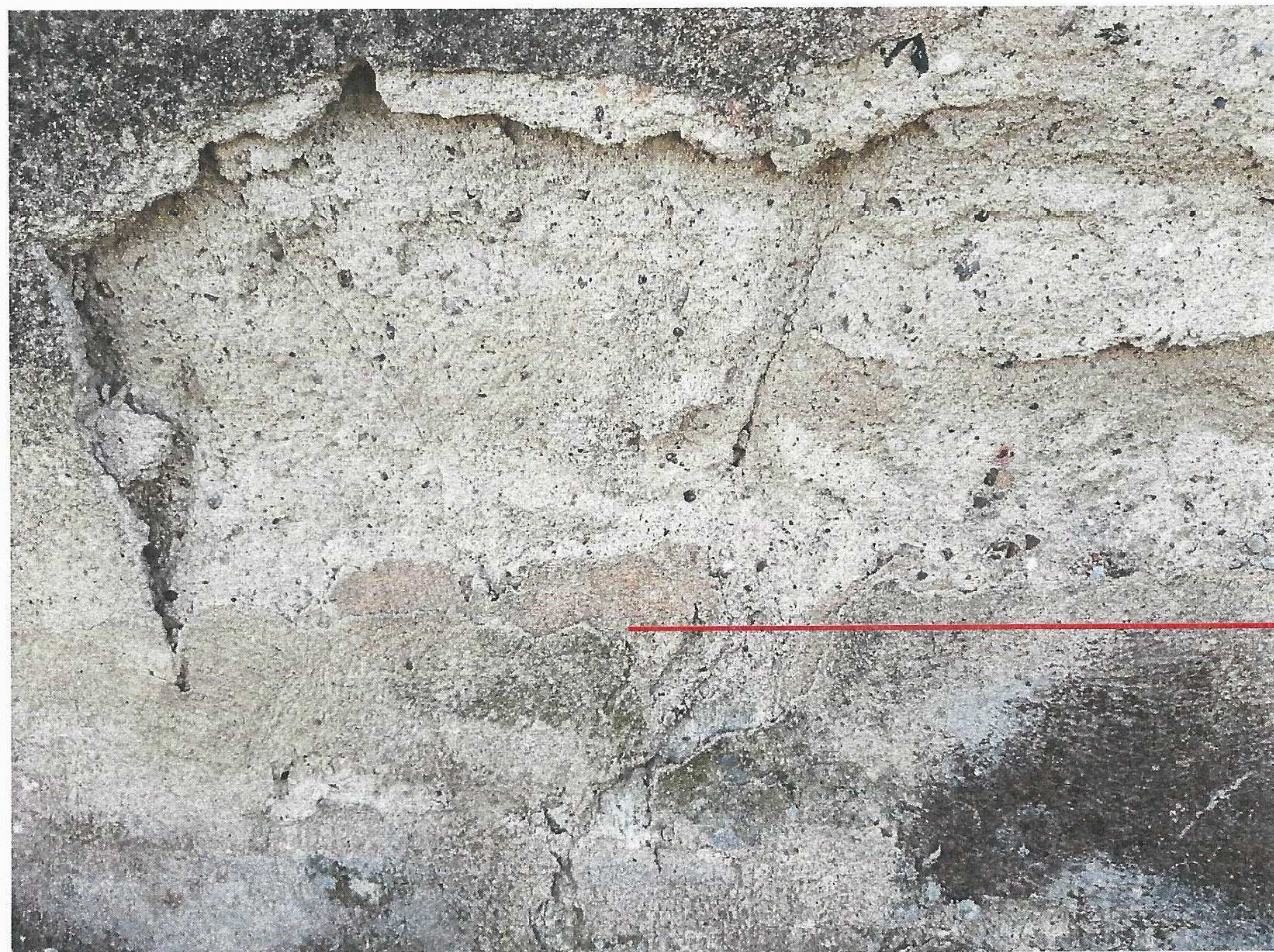
Fot.12. Kościół p.w. Świętej Jadwigi Śląskiej w Gilowie ; fragmenty partii cokołowych elewacji zachodniej zakrystii. Widoczne odspojenia wtórnych tynków odsłaniające zachowane tynki wapienne z relikdami malatury.
