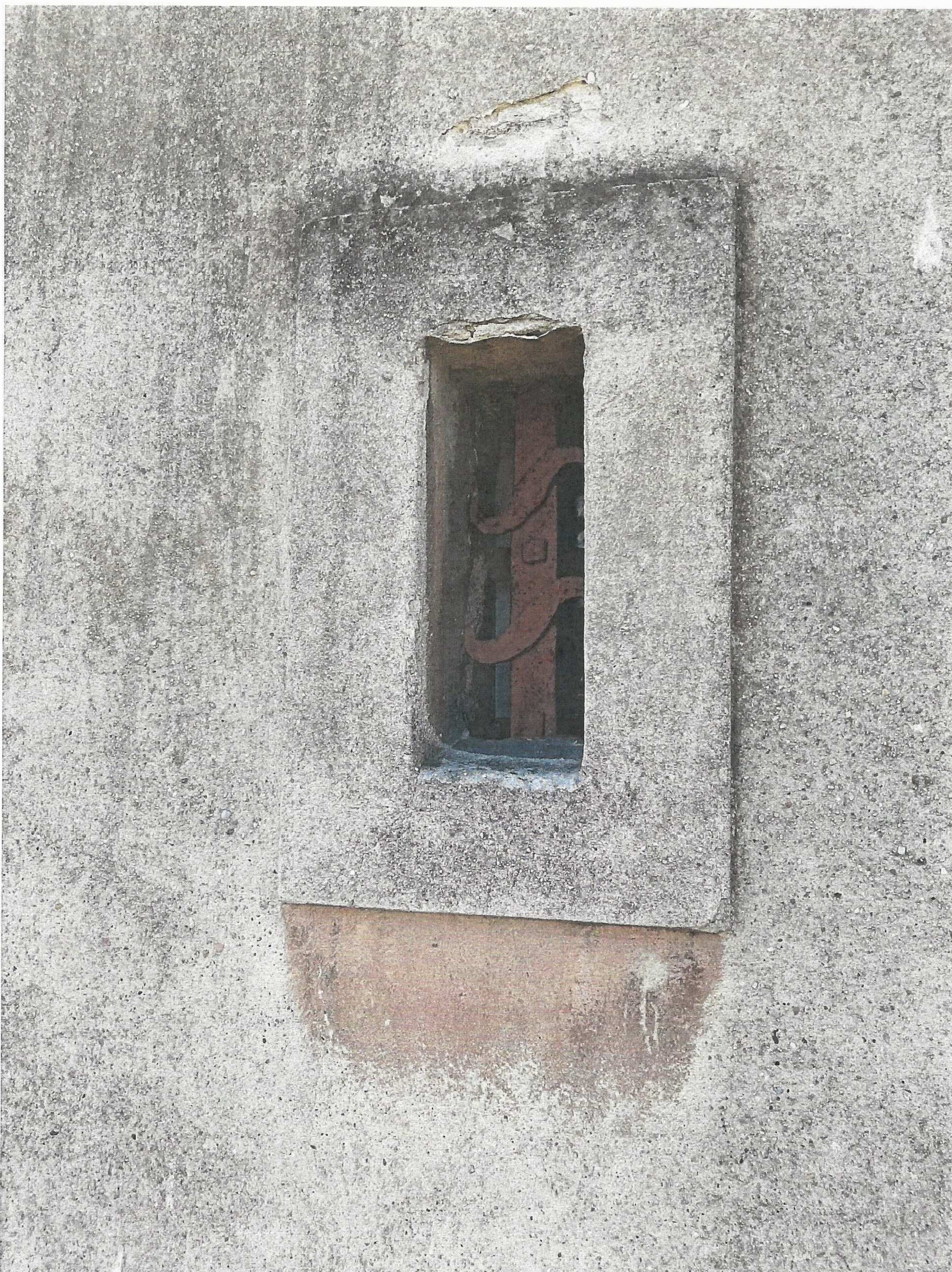
Fot.10. Kościół p.w. Świętej Jadwigi Śląskiej w Gilowie ; fragmenty elewacji zachodniej zakrystii ; widoczne jedno z okienek z formowanym płasko obramieniem , pod którym zachowany relikw malatury [ na pozostałej powierzchni tej elewacji jest ona wymyta ].
