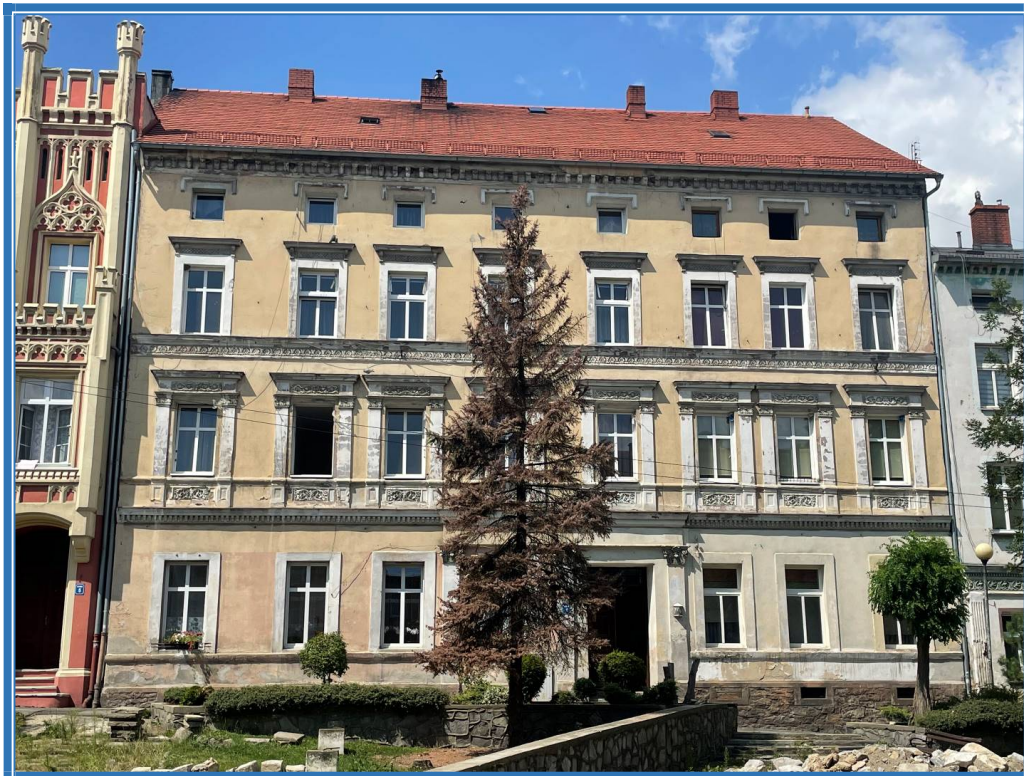
Fot. Nr 1 – Elewacja frontowa – stan istniejący.
