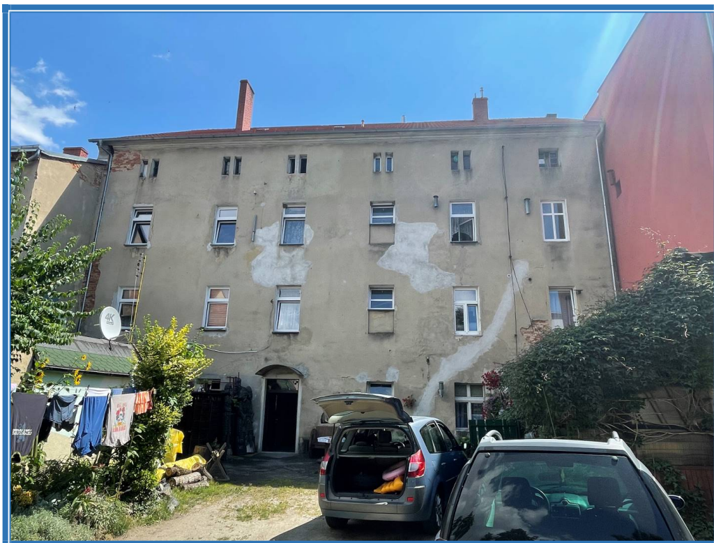
Fot. Nr 2 – Elewacja tylna – stan istniejący.
