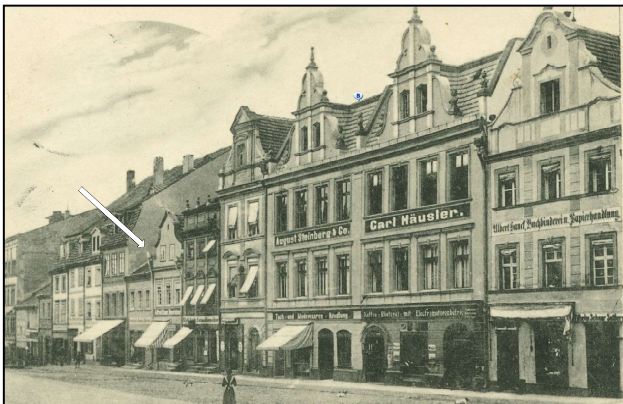
Fot. nr 1 – Widoczna atyka i gzymsy działowe fasady.
