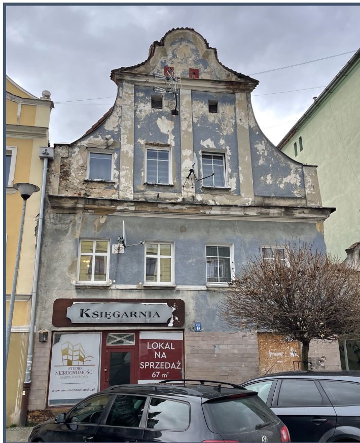
Fot. Nr 1 - Elewacja frontowa - stan istniejący.
