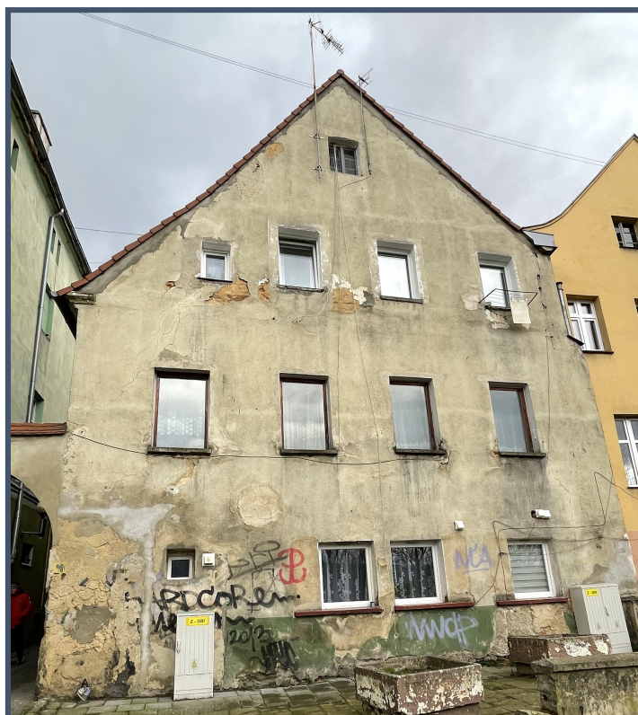
Fot. Nr 2 - Elewacja tylna - stan istniejący.
